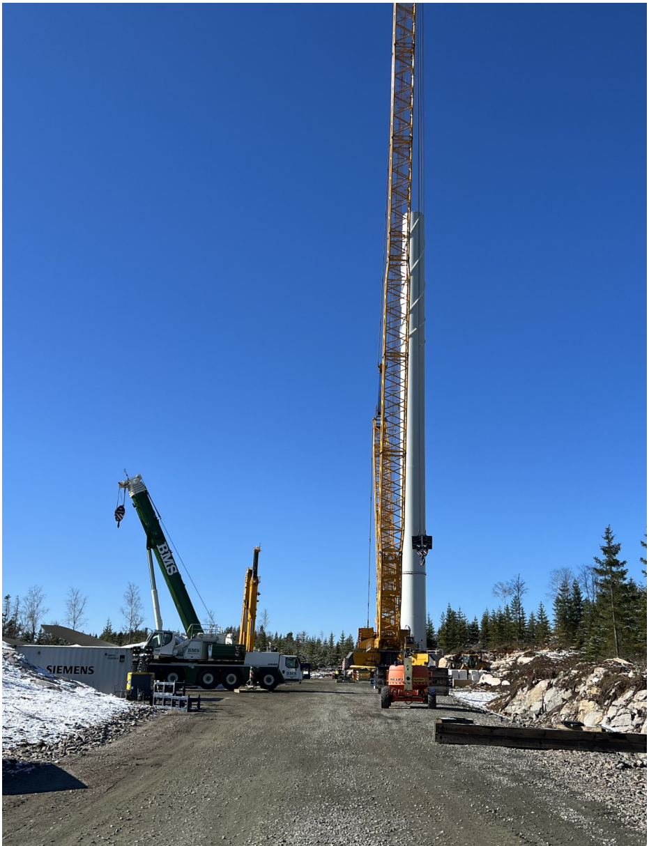
Montering av torndelar vid C31.
